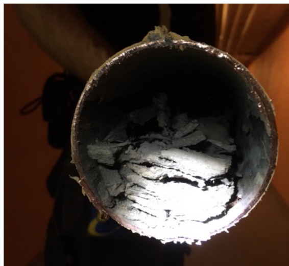
Exempel på rör före sanering
