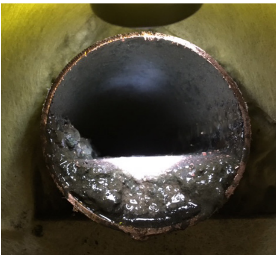
Exempel på rör före sanering
